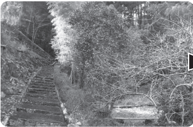
工事前の階段
