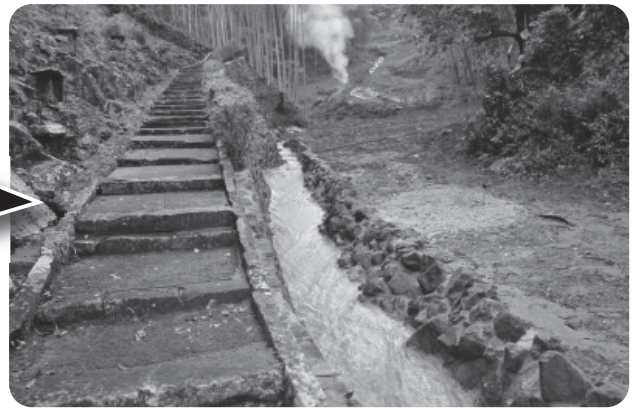
工事後の階段
